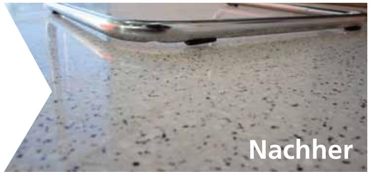
Betonterrazzo mit 5-Stufen RENOVATOR™ und 3 FLEXIS® -Pads-System, durchschnittlicher Glanzgrad 92%; Rutschhemmung 132.
